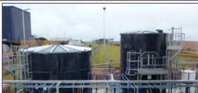
2: Teto com Viga Cônica – Brasil
