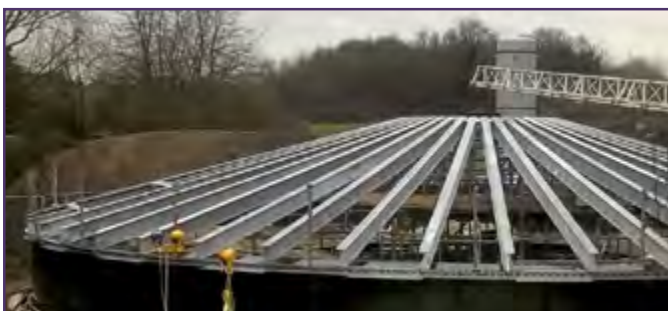
3: Teto com Viga Cônica – Digestão anaeróbia e biogás
