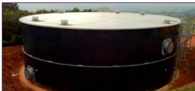
4: Teto Plano de Alumínio – Água potável
