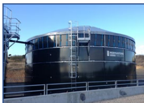
Cubiertas de PVC
