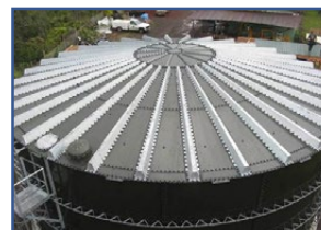
Techo Cónico de Viga Externa
